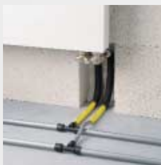
Collegamento di un radiatore al sistema VA®
