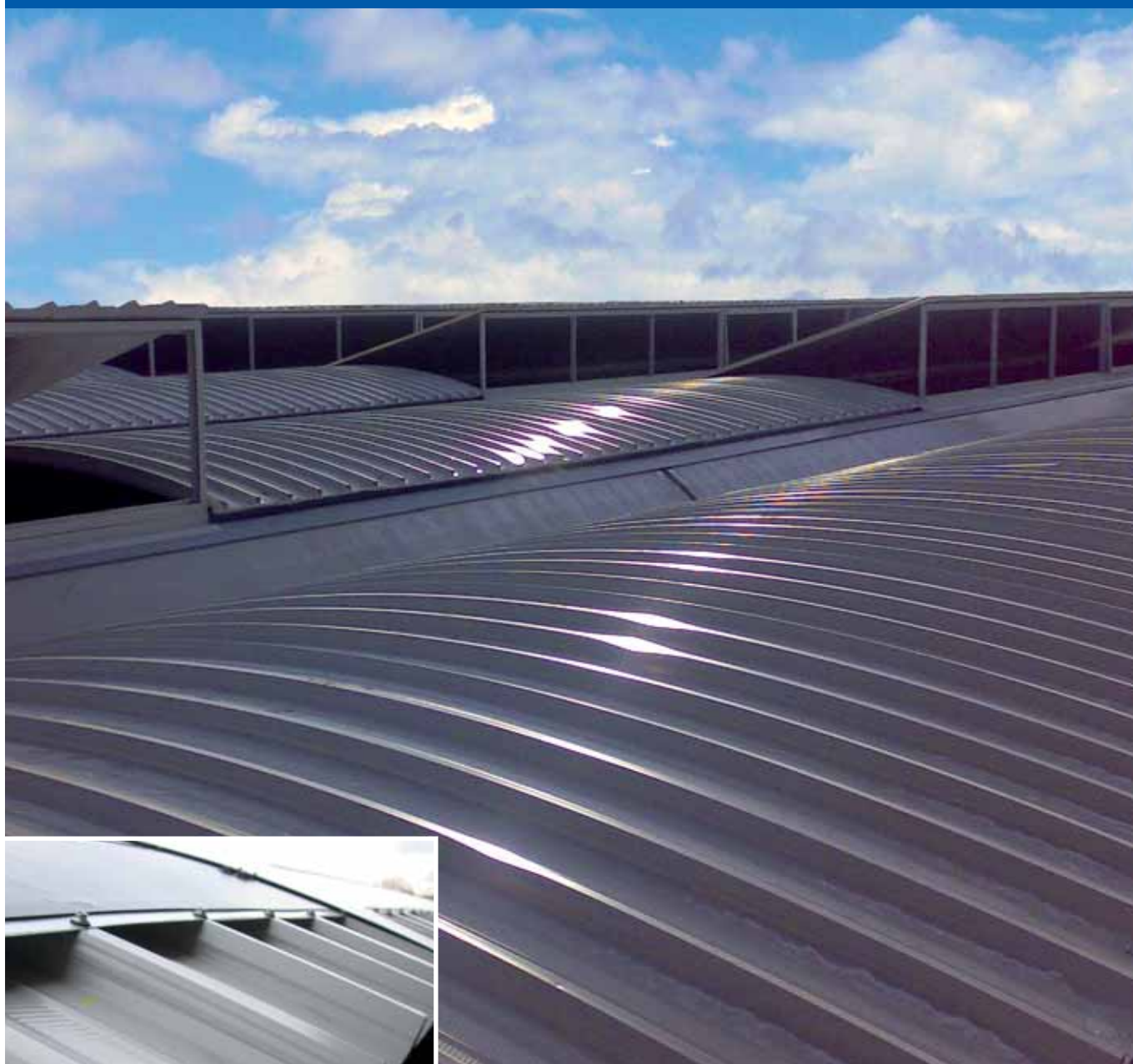
Copertura industriale su prefabbricato in calcestruzzo
