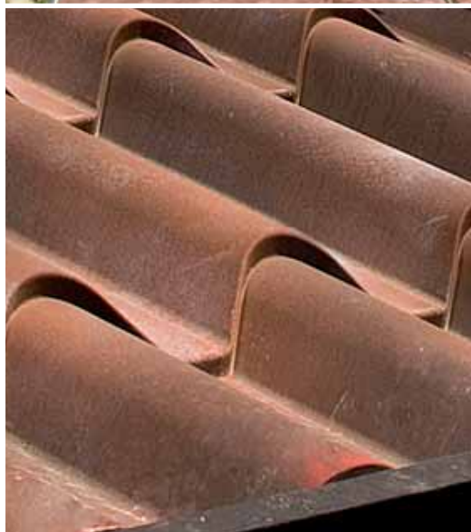
Dettaglio della copertura
