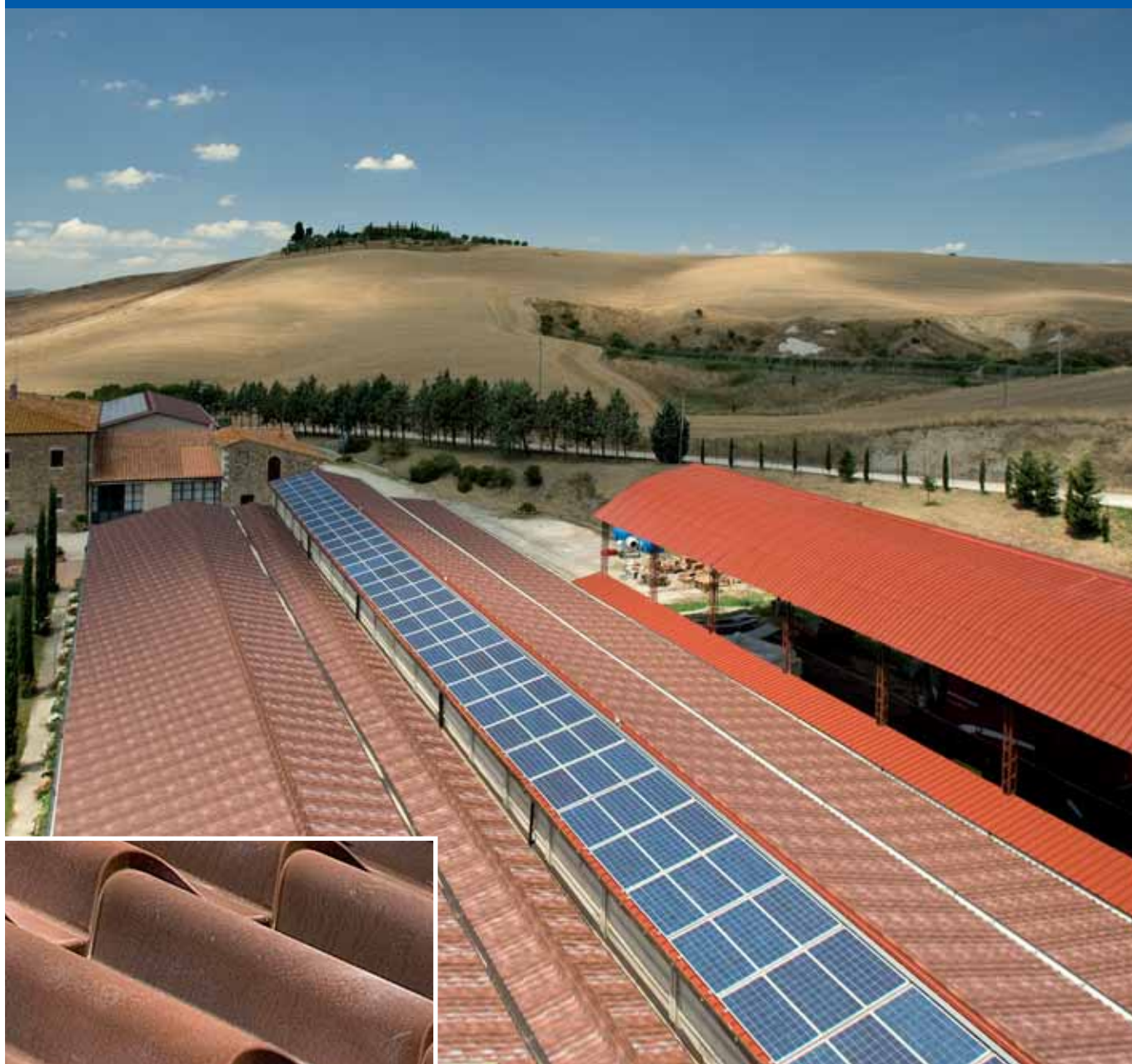
Ristrutturazione Cascinale in località Pienza - Siena
